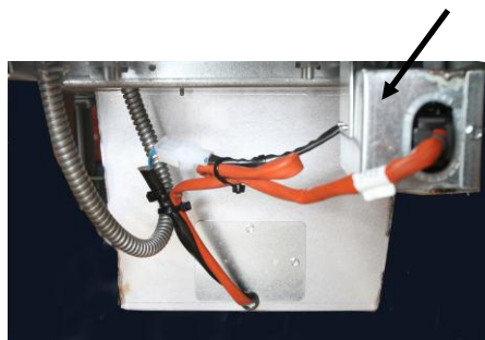
Obrázek 3: Připojte černý konektor do pomocné skříně, jak je znázorněno na obrázku. Samostatný kabelový svazek s bílým konektorem, je-li k dispozici, se NEPOUŽÍVÁ .
