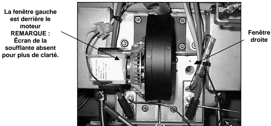
Le mélange air/gaz est correctement réglé quand la pression dans la rampe des brûleurs correspond au tableau applicable de la page 5-8 et que les brûleurs émettent une lueur orange-rouge vif. Si la flamme est bleue ou s'il y a des taches sombres sur la face d'un brûleur, vous devrez ajuster le mélange air/gaz.
