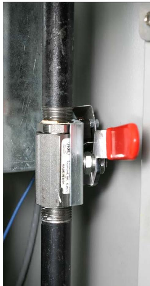
La manija de la válvula de escape del aceite se demuestra en la posición de reposo. Empújelo hacia abajo para descargar el aceite de la cacerola del filtro.
