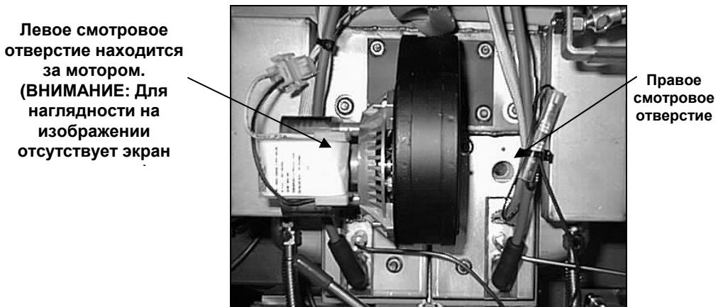
Пропорция газ-воздух отрегулирована должным образом в случае, если давление газа на коллекторе нагревателя находится в соответствии с данными соответствующей таблицы на странице 2-7, а пламя нагревателя ярко-красное/оранжевое. Если пламя синее или если на поверхности нагревателя видны темные пятна, измените пропорцию газ-воздух следующим образом:
