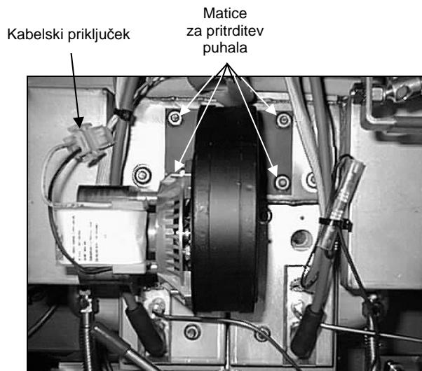
2. Odstranite tri spojnice, s katerimi je motorni sklop puhalo pritrjen na ohišje puhalo in ločite oba dela.
