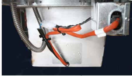
الشكل 3: وصل الموصل الأسود داخل صندوق الاستخدام كما هو موضح، ويحظر استخدام مجموعة أسلاك منفصلة، في حالة إرفاقها، مع قابس أبيض.
