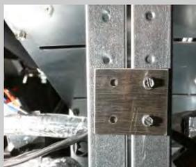
Накладки из листового металла фиксируют части шкафов.
