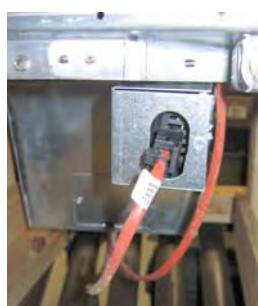
**Obrázek 6:** Upevněte dvoukolíkové bílé konektory a připojte černý konektor k výstupní skříně podle obrázku. \* Povšimněte si, že poloha černého konektoru se může lišit od fotografie.
