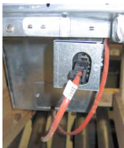
Фигура 6: Прикрепете двуцифтовите бели конектори и включете черния конектор в помощната кутия, както е показано. * Имайте предвид, че позицията на черната връзка може да се различава от снимката.
