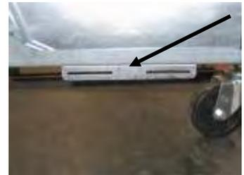
**Abbildung 1:** Befestigen Sie Ausrichtungshalterung am Boden der ATO-Gehäusestrebe.
