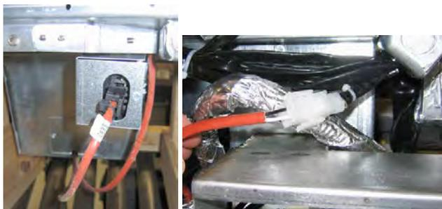
**Figura 6:** Conecte los conectores blancos de dos patillas y enchufe el conector negro en la caja eléctrica como se muestra. \* Tenga presente que la posición del conector negro puede ser distinta a la posición de la foto.
