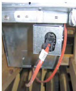
Figure 6 : Fixer les connecteurs blancs à deux broches et brancher le connecteur noir dans la boîte de connexion comme illustré. * Noter que le raccord noir peut différer de la photo.
