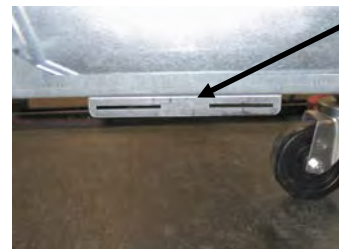
Figure 1 : Fixer le support d'alignement au bas du renfort de boîtier ATO.
