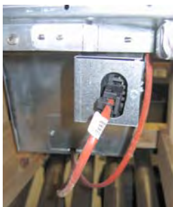
Figure 6 : Fixer les connecteurs blancs à deux broches et brancher le connecteur noir dans la boîte de connexion comme illustré. * Noter que le raccord noir peut différer de la photo.
