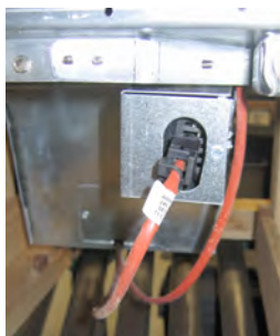
Afbeelding 6: Bevestig de twee-pens witte aansluitingen en steek de zwarte aansluiting in de doos zoals aangegeven. * Merk op dat de positie van de zwarte connector kan verschillen van de positie op de foto.
