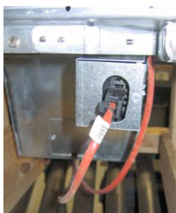
Рис. 6. Прикрепите белые двухштырьковые соединители и вставьте черный соединитель во вспомогательный блок, см. рис. *Обратите внимание: расположение черного соединителя может отличаться от показанного на фотографии.
