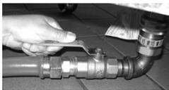
Установите ручной отключающий кран системы подачи газа в положение ON («ВКЛ.»). Включите контроллер с целью проверки системы зажигания горелок. После успешной проверки выключите контроллер.
