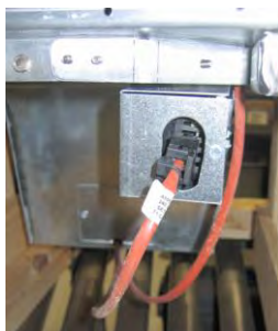
Figura 6: Collegare i connettori bianchi a due pin e collegare il connettore nero alla scatola di servizio, come mostrato. * Si noti che la posizione del connettore nero potrebbe essere diversa da quella nella foto.
