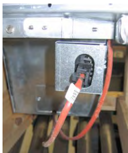
Rysunek 6: Zamontuj i podłącz białe złącza dwustykowe do czarnego złącza w skrzynce uniwersalnej, jak pokazano na rysunku. * Należy zwrócić uwagę, że pozycja czarnego złącza może różnić się od tego na zdjęciu.
