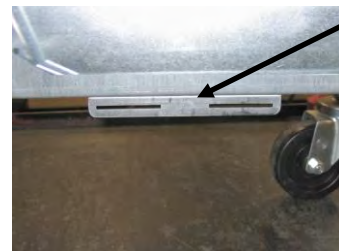
Hình 1: Gắn nẹp ở đáy thanh giằng hộp ATO.
