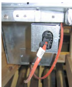
Hình 6: Cắm giắc nối 2 chân màu trắng và giắc cắm màu đen vào hộp như chỉ dẫn. * Lưu ý vị trí khớp nối đen có thể khác với hình ảnh.
