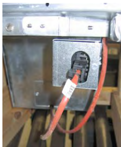
Kuva 6: Liitä kaksineulaiset valkoiset liittimet ja kiinnitä musta liitin esitetyllä tavalla pistorasiaan. * Huomaa, että musta liitäntä saattaa erota kuvasta.
