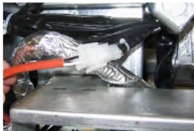
Obrázok 6: Pripojte dvojkoľkové biele konektory a zasuňte čierny konektor do skrinky inžinierskych sietí podľa obrázka.
