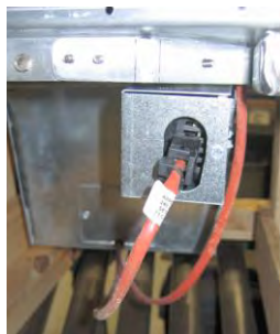
Obrázek 6: Propojte dvoukolíkové bílé konektory a zapojte černý konektor do elektroinstalační krabice podle vyobrazení. * Poloha černého konektoru se může lišit od vyobrazení na fotografii.
