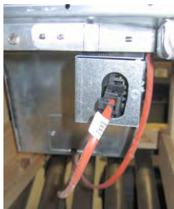
Εικόνα 6: Προσαρτήστε τους λευκούς συνδέσμους δύο ακίδων και συνδέστε τον μαύρο σύνδεσμο στο κουτί συνδέσεων, όπως στην εικόνα.
