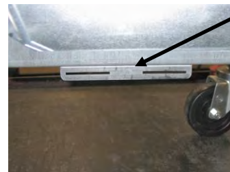
Слика 1: Закачите поравнавајући држач за дно подупирача АТО кутије.
