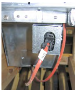
Слика 6: Закачите двоигличасте беле конекторе и уметните црни конектор у комуналну кутију како је приказано.
