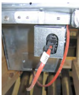
Figur 6: Fäst de vita tvåstiftskontakterna och koppla in den svarta kontakten i elskåpet så som visas. * Observera att placeringen av den svarta kontakten kan avvika från den som visas på bilden.
