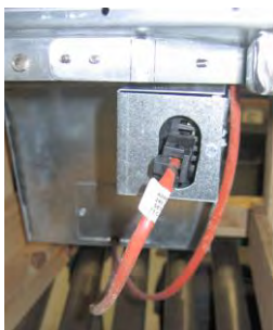
Kuva 6: Liitä kaksinapaiset valkeat liittimet ja kytke musta liitin pistorasiaan, kuten kuvassa. * Huomaa mustan liitännän asento voi olla erilainen kuin kuvassa.
