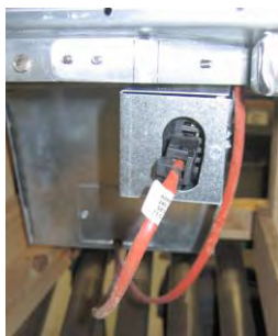
Figur 6: Forbind de tobenede hvide stikforbindelser, og tilslut det sorte stik til stikkontakten som vist. *Bemærk, at placeringen af det sorte stik kan afvige fra billedet.
