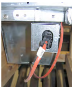
Figura 6: Conecte os conectores brancos de dois pinos e conecte o conector preto na caixa de utilitários, conforme mostrado. * Observe que a posição da conexão preta pode ser diferente da foto.
