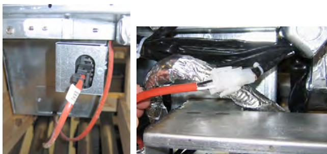
Afbeelding 6: Bevestig de twee-pens witte aansluitingen en steek de zwarte aansluiting in de doos zoals aangegeven. * Merk op dat de positie van de zwarte connector kan verschillen van de positie op de foto.
