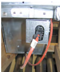
図 6：上の写真の通りに、白い 2 ピンコネクタを取り付け、黒いコネクタをユーティリティボックスに挿し込みます。* 黒い接続部の実際の位置は写真と異なる場合がありますのでご注意ください。
