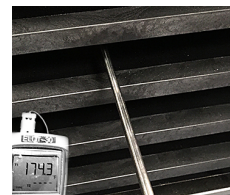
Kaikkien lämmityslevyjen lämpötilat testataan pyrometrin lukemaa vastaan.
